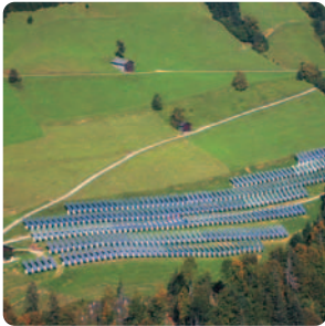
Pequeña central eléctrica
