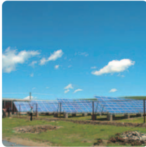
Pequeña central eléctrica
