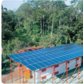
Sistema de telecomunicaciones
