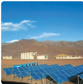
Pequeña central eléctrica
