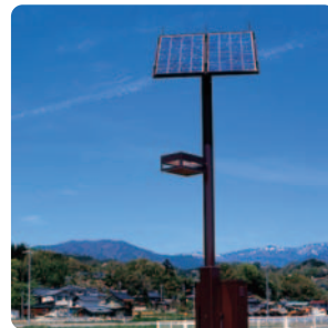
Iluminación de carreteras
